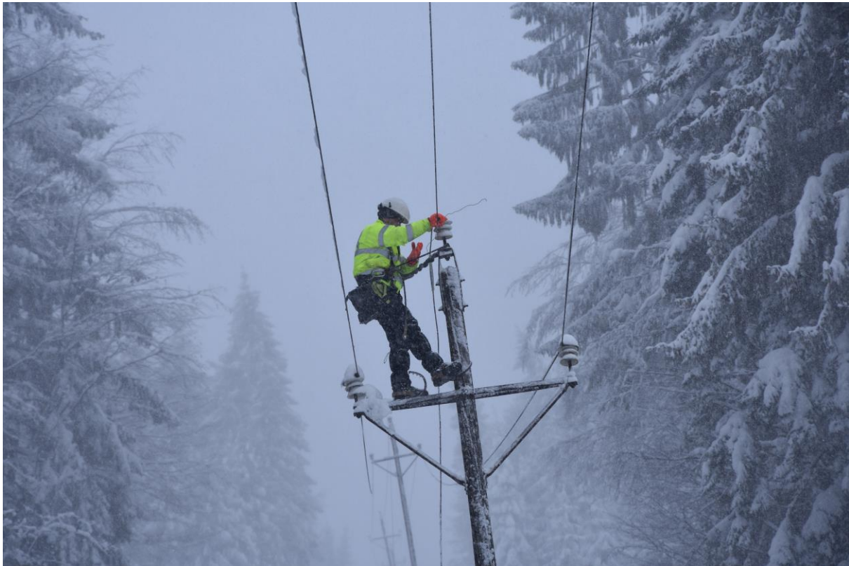
Foto: Opravy na vedení vysokého napätia nad kysuckou obcou Nesluša sprevádzal silný vietor a sneženie.
