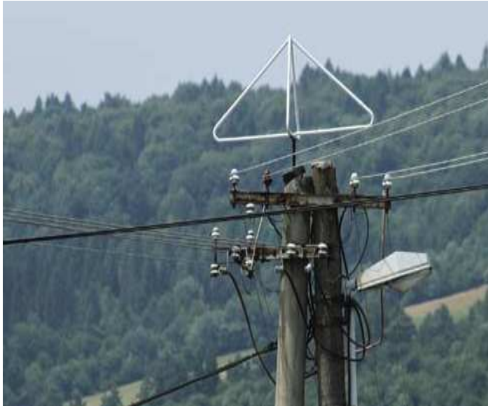
Obr. Zábrana proti bocianom na NN sieti
